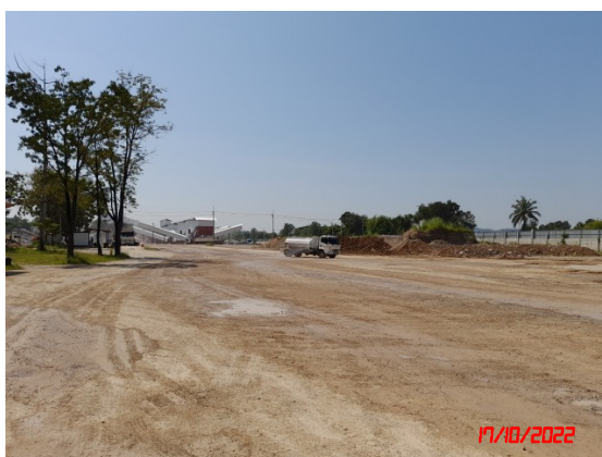
รูปที่ 5 การปรับถมพื้นที่ที่เป็นหลุมบ่อ
